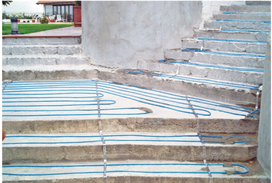
Расположение нагревательных кабелей
