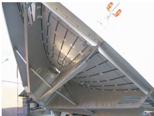
Защита от обледенения мачтовых и параболических антенн
